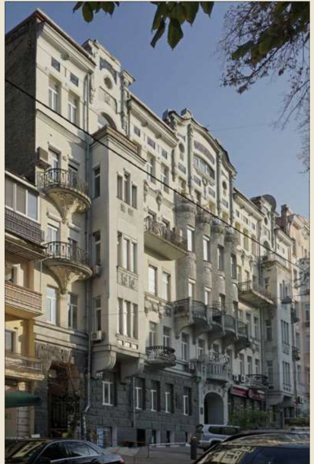
Будинок консульства Великої Британії в Києві (вул. Пушкінська, 21).
