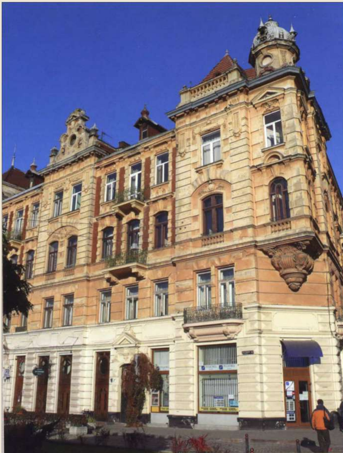
Пл. Соборна, 2а (колишня пл. Бернардинська) від 1906 р. — будівля, де було розташоване Консульське агенство Французької Республіки у Львові
